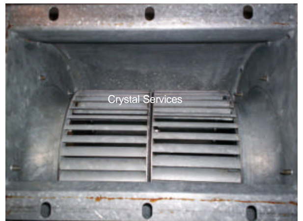
Zuluftventilatoren nachher
