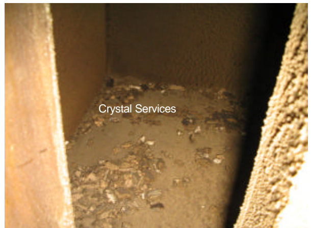
Kanal in der Lüftungsstation Hygiene, Bakterienherde, welche über den Zuluftstrang in die Räumlichkeiten befördert wird
