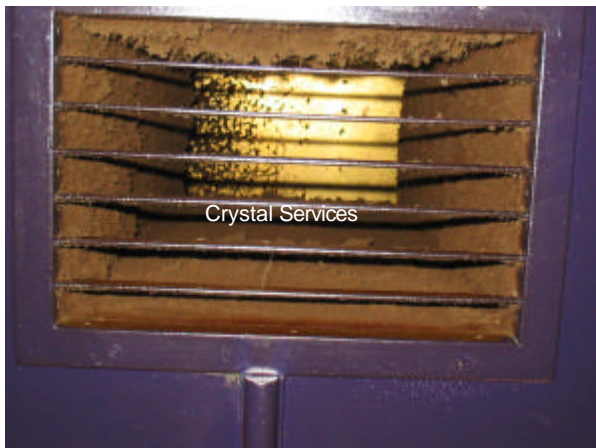
Kanal hinter den Lüftungsgittern
